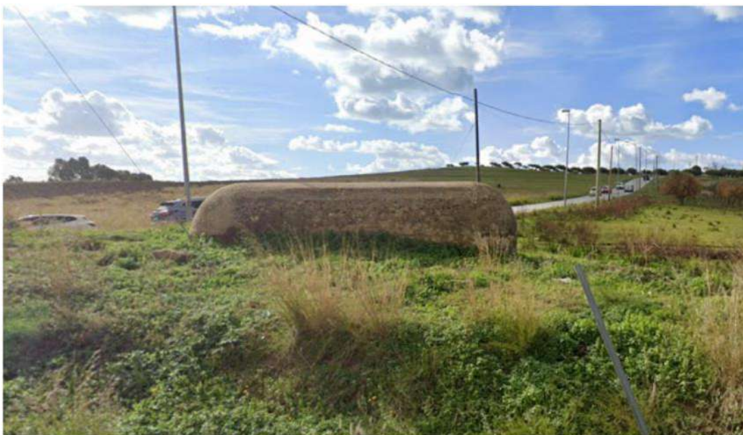
Ubicazione del bunker. Fonte: scatto fotografico eseguito in sito – vista dalla Viabilità complanare alla S.S.115
