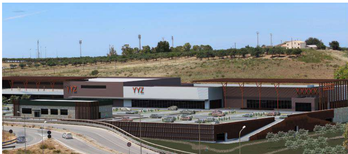
Fotoinserimento dell'insediamento commerciale proposto dal PPA: Veduta ravvicinata della porzione nord dell'insediamento commerciale su impalcato destinato a parcheggio interrato e seminterrato
